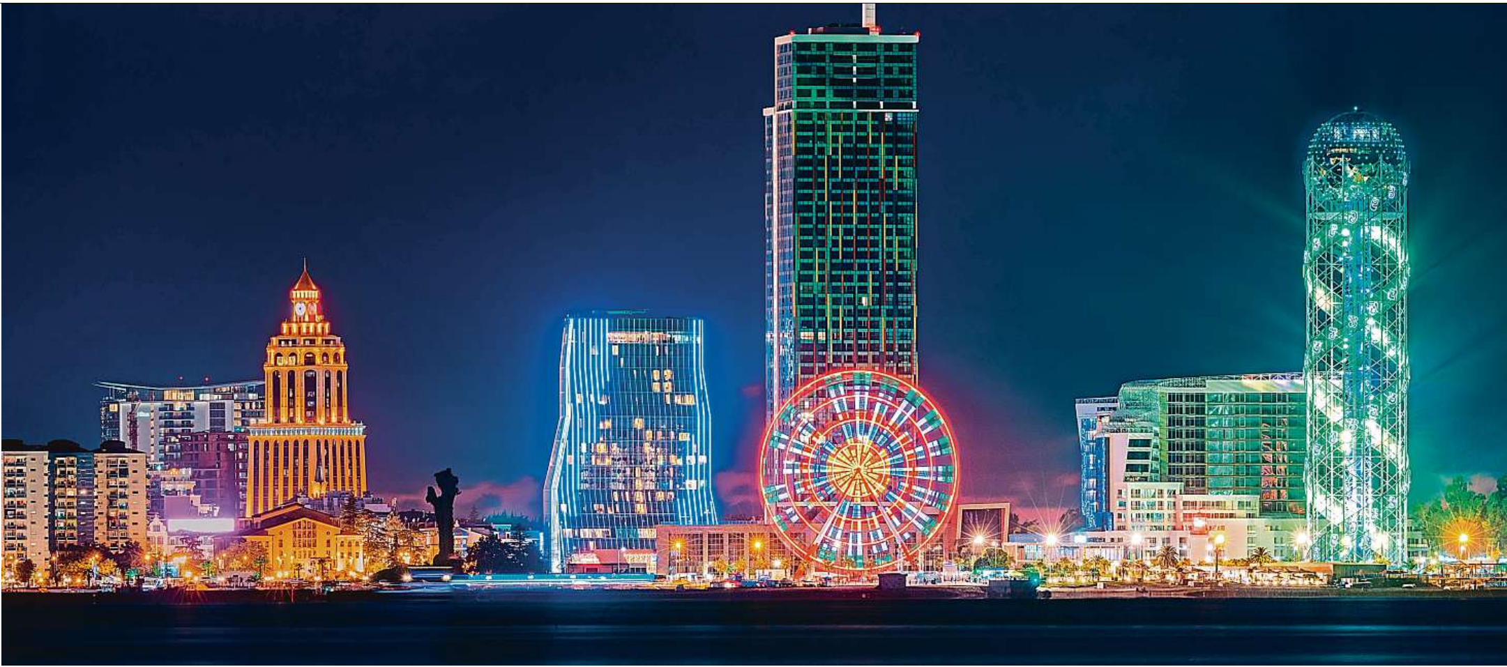
Barevná podívaná Moderní věžáky z betonu a skla v Batumi pomalu vytlačují staré budovy. Výstavba přitom není zdaleka u konce, narazit na staveniště uprostřed města není ničím výjimečným. Foto: archiv
